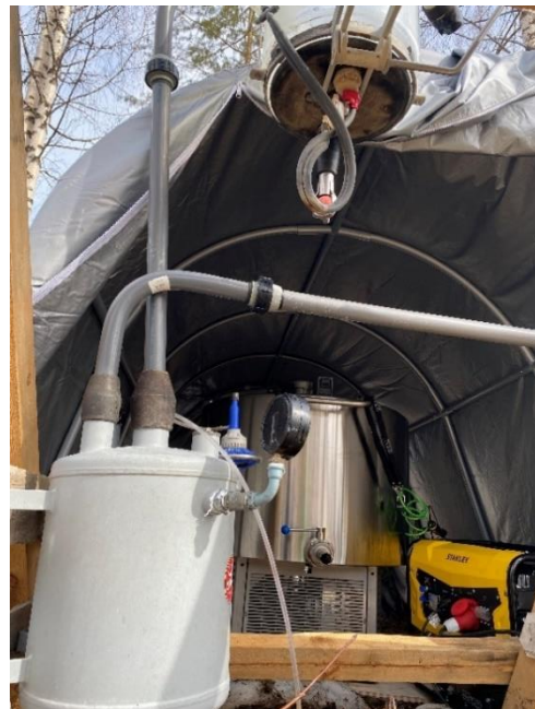
Kuva 71. Alipaineistettu valutuslinjasto toimii sähköllä, joka voidaan maastokohteeseen tuoda aggregaatilla tai aurinkopaneeleilla.
